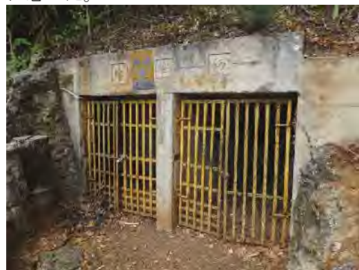
▲スペイン広場付近に残る旧日本軍が掘った防空壕。放射能注意標識も見える。
