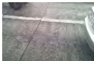
写真 12 : ほうき目仕上げ
