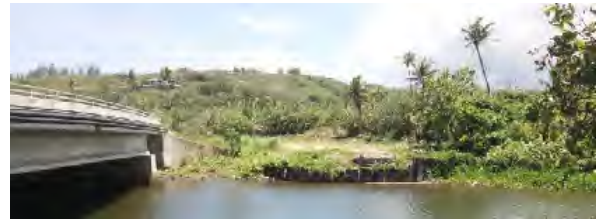
写真 13 : 橋梁と鋼矢板式護岸
