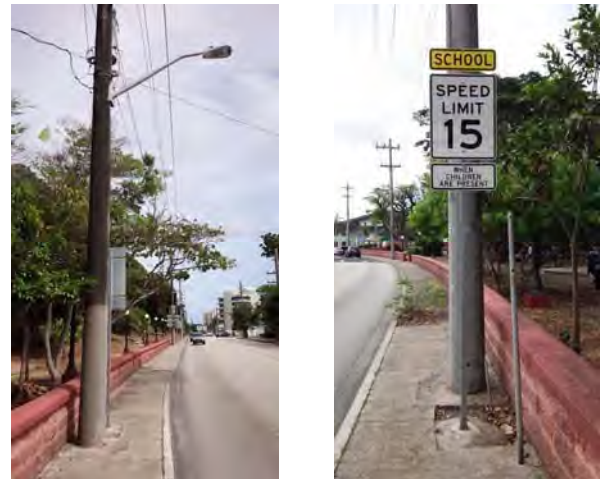
道路照明と道路標識(速度規制)
