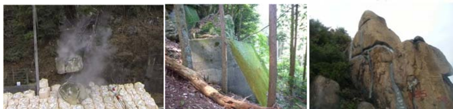
除去 消除 根固め 根巩固 岩盤接着 岩盘粘着
