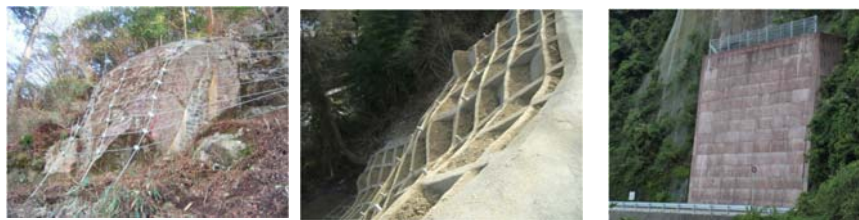
ロープ掛け 绳架 吹付法枠 吹付法框 軽量コンクリート擁壁 轻量混凝土护墙
