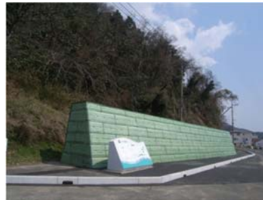
落石防護補強土壁 石头滑落防护加强土壁
