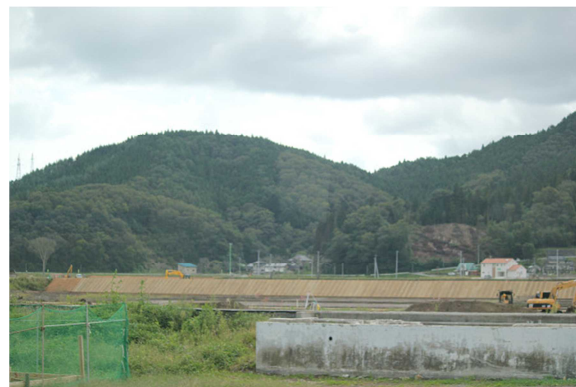
破堤した気仙川右岸堤防の復旧工事
