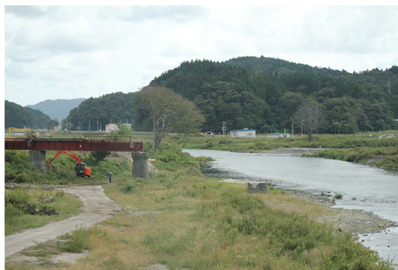
津波で流失した大船渡線の鉄道橋
