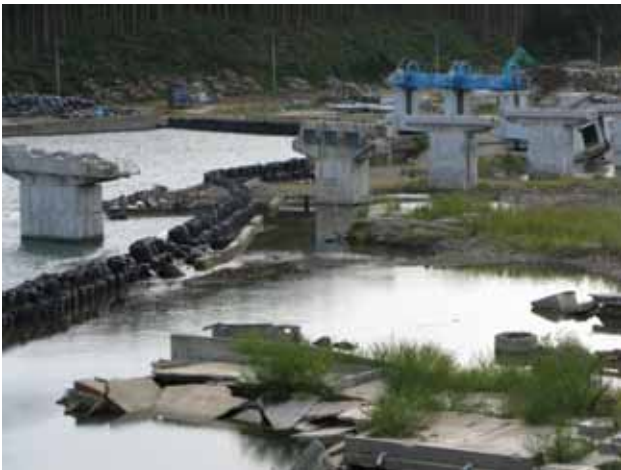
津波による土地と道路橋上部の流失
