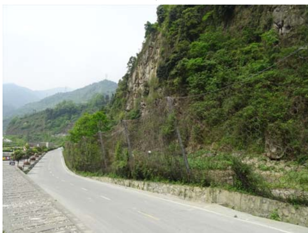
写真 16 中国の落石防護工
