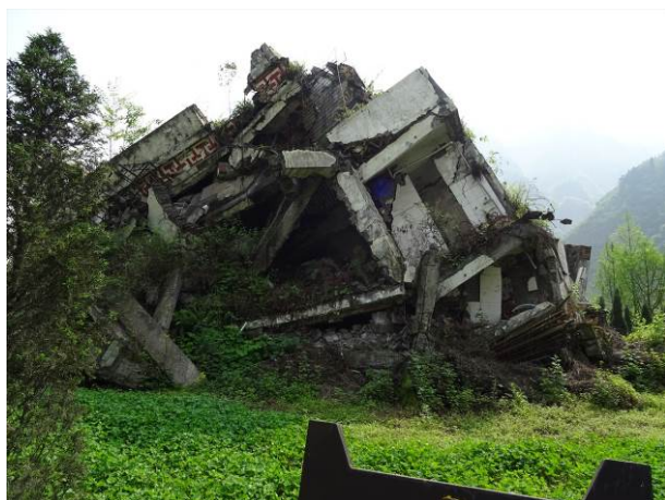
写真12 倒壊した中学校
