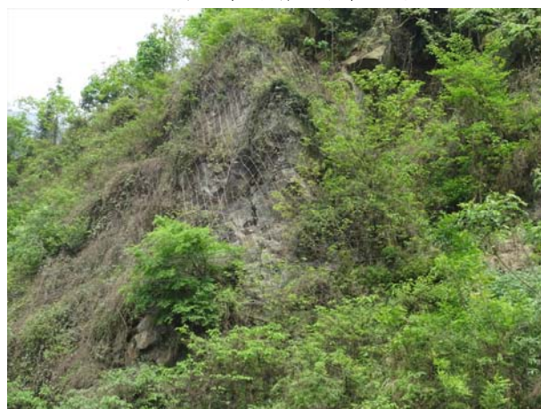
写真 17 中国の落石予防工
