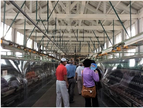
小屋組は木造のキングポストトラス。
