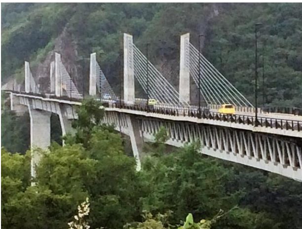
道の駅八ッ場ふるさと館の側に架かっている不動大橋。「PC 複合トラス」と「エクストラドロード橋」の技術を融合した世界初の鋼・コンクリート複合トラス・エクストラドロード橋。橋長 590m。支間 63.4m+125m+2@155m+88.4m 。
