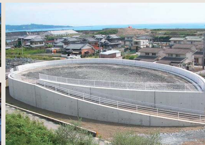
建設中の津波避難広場
