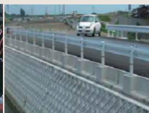
施工されたプレガード
