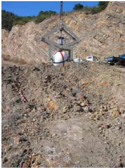
写真-1 コンクリート球と離脱装置
