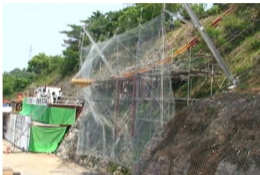
図-8 1.0tの重錘を衝突させたときのネットの変形 5)
