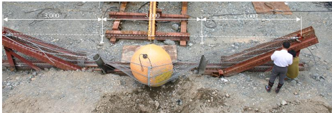
写真3 防護柵の変形
