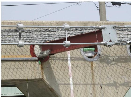
中間支柱の H 形鋼が、重錘を受けたときにねじれて横方向（弱軸方向）に変位することにより強度を失うのを防止するため、支柱の付け根には下部拘束枠、上部には、ねじれ拘束枠及び連結棒が取り付けられている。
