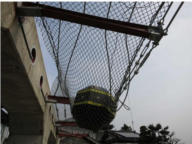
金網ワイヤロープ式の通常の落石防護柵には、 $\phi 3.2\text{m}$  の菱形金網が使用されているが、ストロンガー工法には、素線 $\phi 2.6\text{mm}$ 3本よりワイヤ金網が使用されている。
