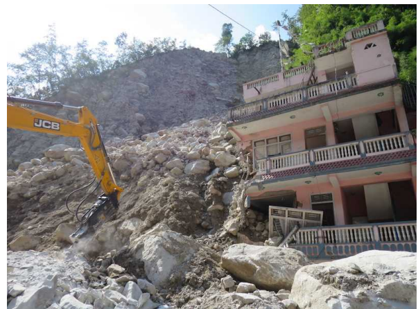
写真 6 遷急線を頭部とする斜面崩壊
