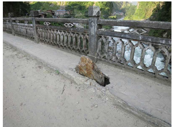
写真 8 落石が直撃した橋梁の床版
