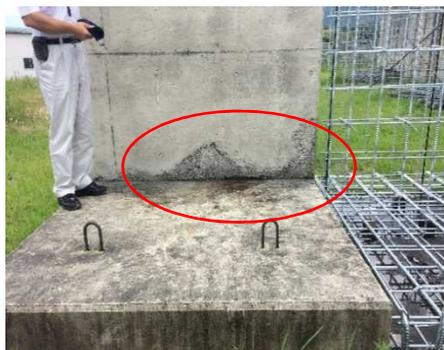
写真1:ジャンカが起きた逆T式擁壁
