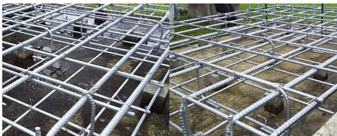
写真5 主筋・配筋の配置ミス
