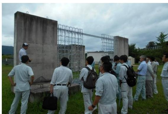
写真① 逆 T 式擁壁モデル
