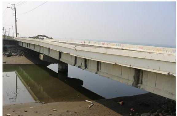
文安橋は中華民國 84(1995)年 9 月に竣工したポストテンション方式の 2 径間単純 PCI 桁橋である。
