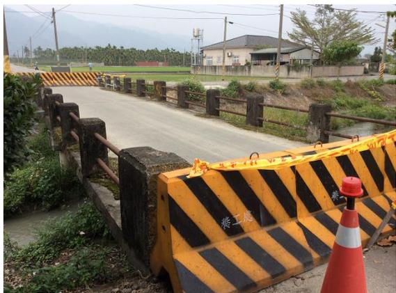
支間10mの2径間の鉄筋コンクリートT桁橋。橋脚はパイルベント方式。
