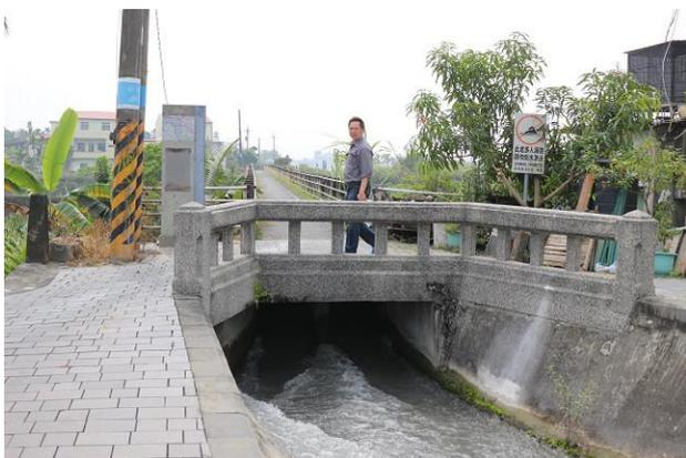
箱桁断面の水路橋の上が歩道になっている。
