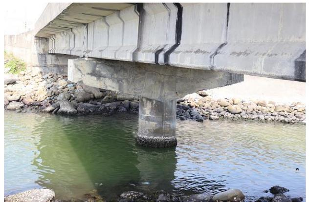
海尾橋は中華民国 83(1995)年 8 月に竣工したポストテンション方式の 2 径間単純 PCI 桁橋である。この橋も塩害を受けていた。塩害に関しては、文安橋と同様に上流側の梁下の損傷が大きい。
