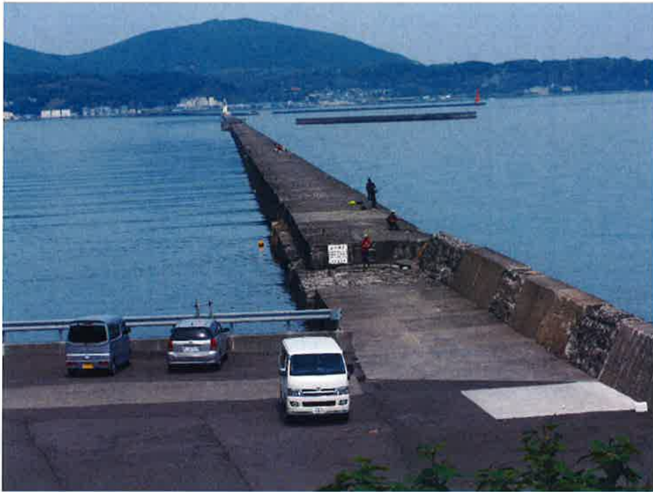
小樽港南・北防波堤（南部より北方を望む）
