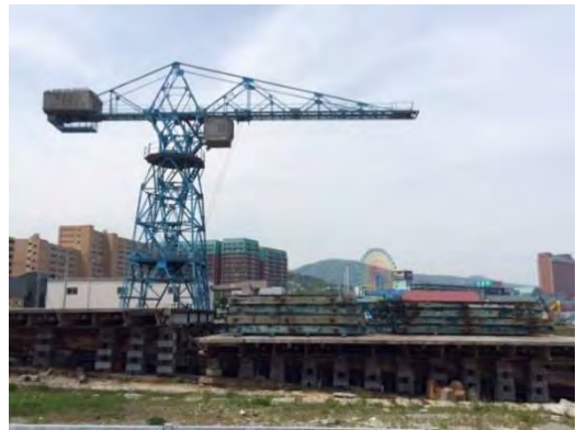
斜路式ケーソン制作ヤードの様子
