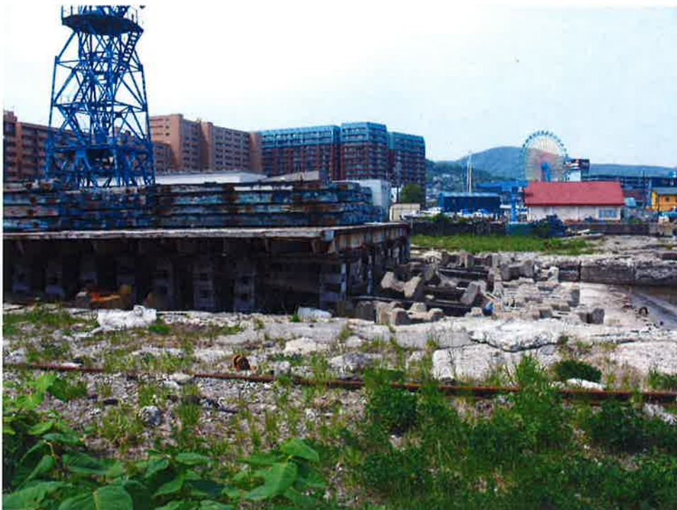
小樽港斜路式ケーソン制作ヤード(廣井勇の 弟子で事業後継者の伊藤長右衛門が考案)
