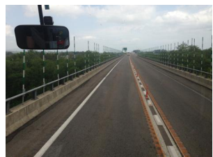
路肩の視線誘導ポール
