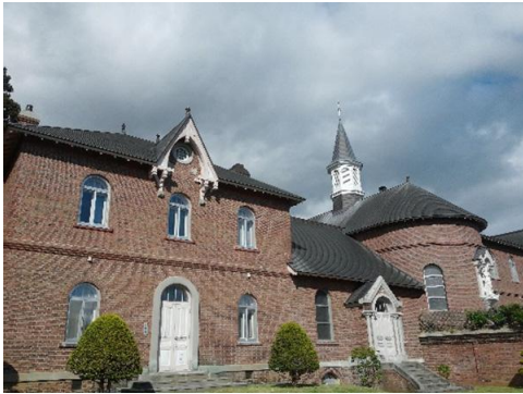
修道院の礼拝堂と司祭室
