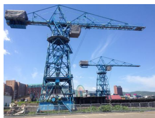
斜路式ケーソン製作ヤード
