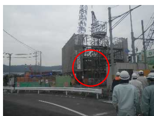
写真 2-1 オープンケーソン工法の施工状況
