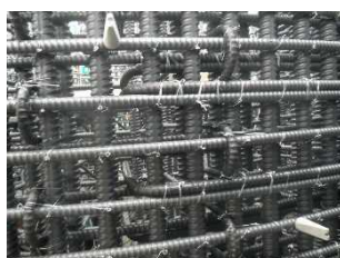
写真 2-2 鉄筋の配置状況
