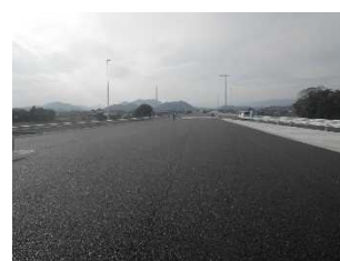
写真 3-3 舗装完成状況
