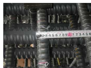
写真 2-3 鉄筋直径計測
