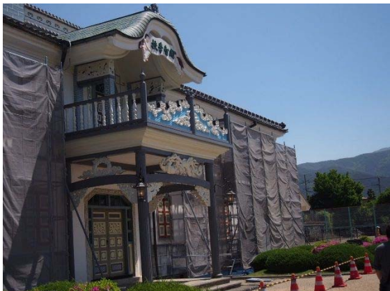
工事中の旧開智学校
