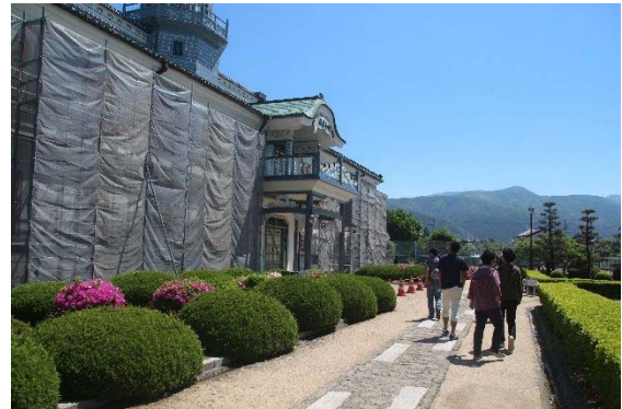
工事中の旧開智学校
