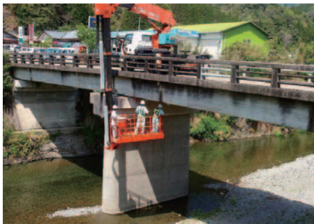
橋梁点検調査
