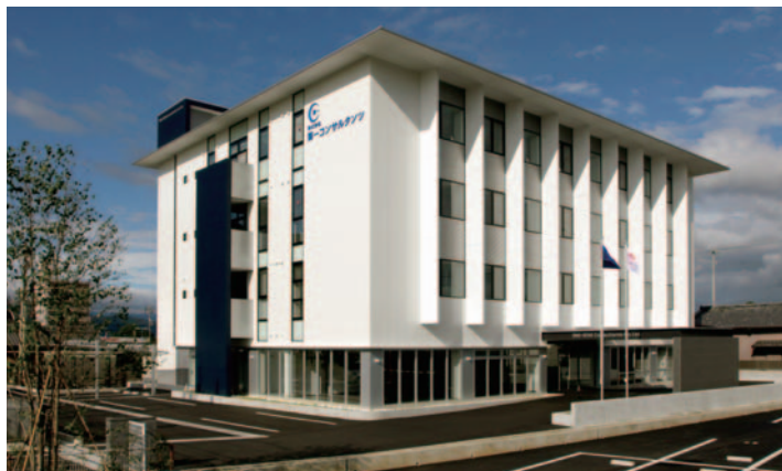
公共施設と同等の耐震強度を備えた社屋
