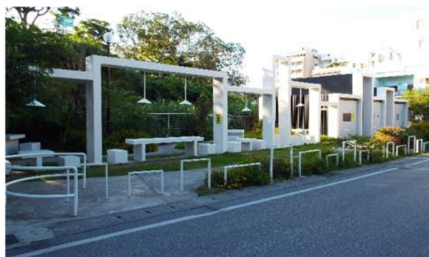
写真6 緑ヶ丘公園エントランススペース公衆便所
