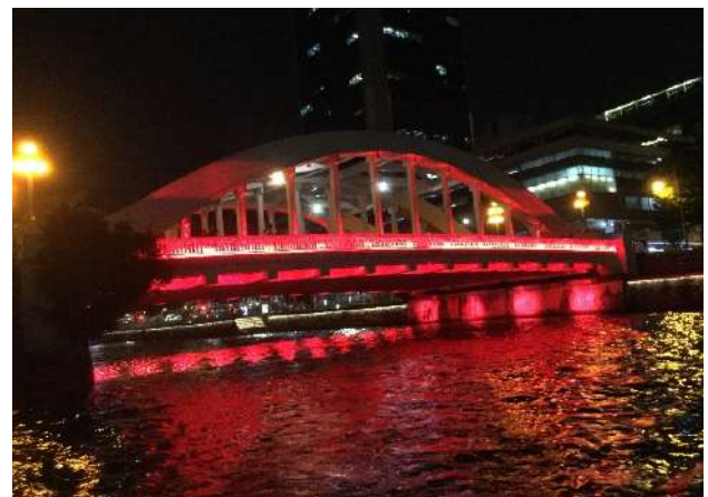
写真8 赤色にライトアップされた夜のエルギン橋
