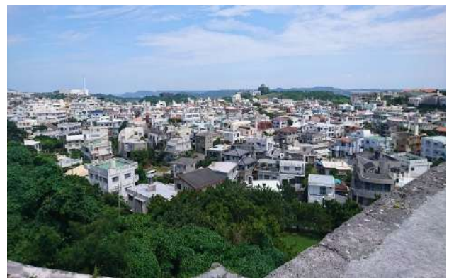
写真3 鉄筋コンクリート造建築物が立ち並ぶ那覇市街地
