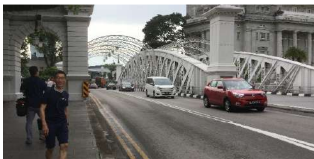
写真1 アンダーソン橋
