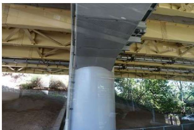
写真1 高速道路の橋梁
