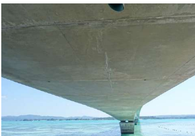
写真5 上部工損傷状態
