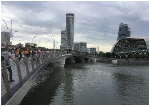
写真5 下流側から見たエスプラネード橋
