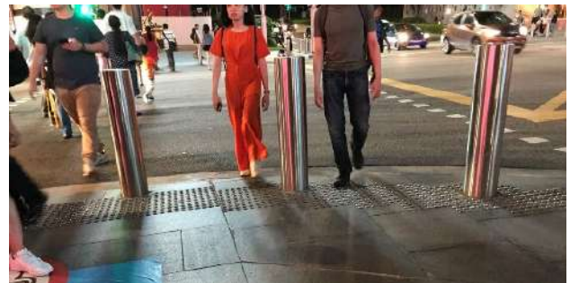
図5 交差点の歩道に設置された車止め ステンレス製で強固に見える。オーチャード
