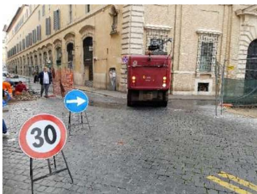
写真 4-3 フロントでブラシが回転している清掃車、左のほうでは石畳を剥がして工事中
