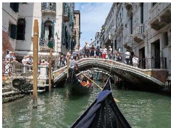
写真-5 端部が拡幅された橋(側面)
