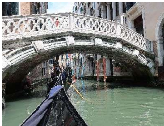
写真-3 高欄が美しい橋(側面)
