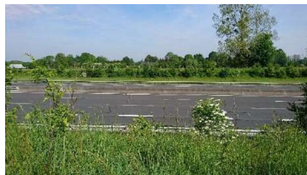
高速道路本線側面
