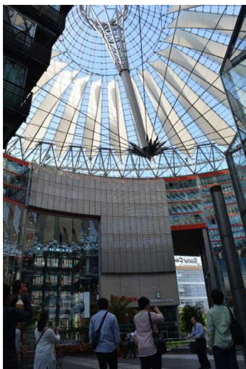
中庭から見上げた様子
