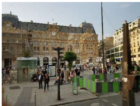
写真9 補修中の建物や歩道
