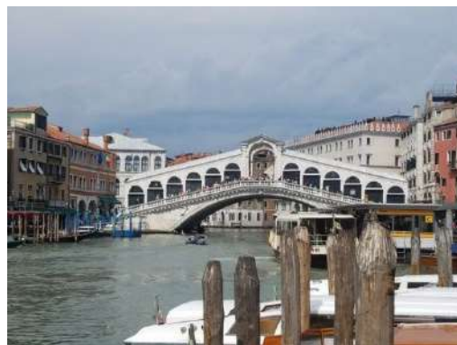
13世紀に建設されたリアルト橋
