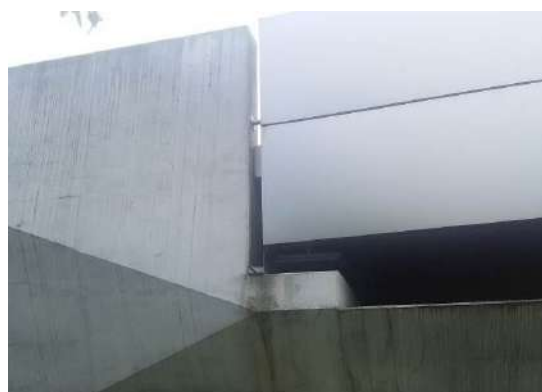
写真4 伸縮装置の排水処理
