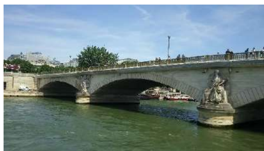
セーヌ川に架かる橋(コンクリート橋)
