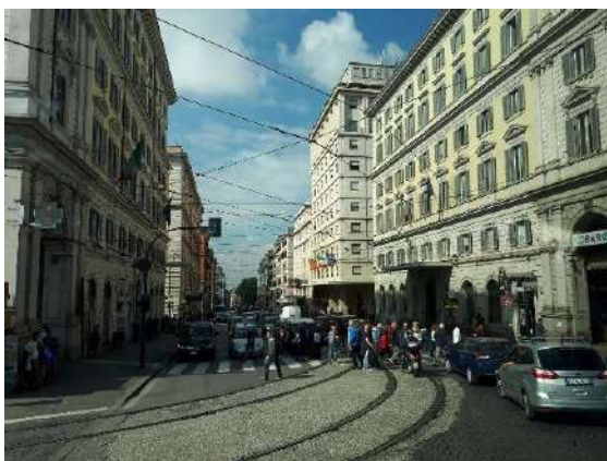
写真 5-1 路面電車の架線状況
