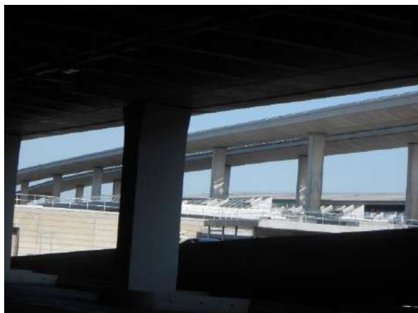
空港連絡道路の橋脚
