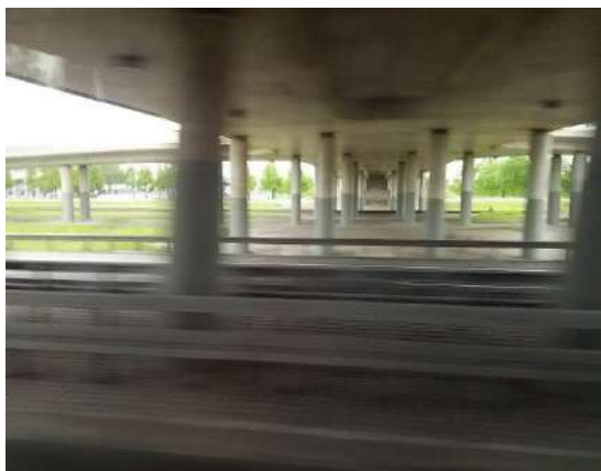
写真1 アウトバーンを跨ぐ橋の橋脚
