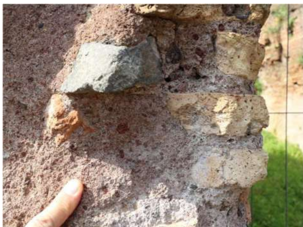
写真5 古代コンクリート 黄土色の板状レンガの内側に、コンクリートが露出している。骨材として赤いレンガ片、緑色岩、黒色のガラス片(?)が見える。
