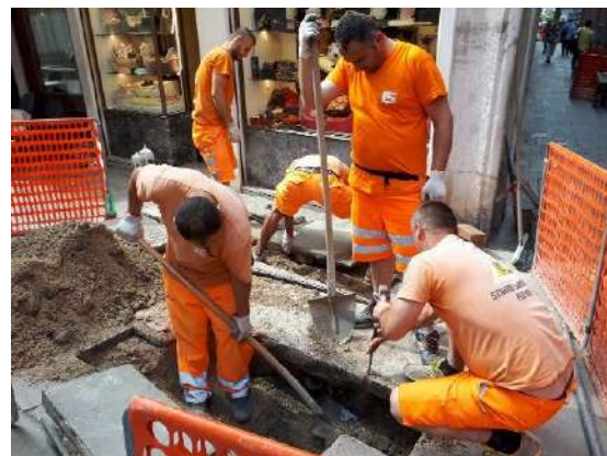
写真 3-5 オレンジが映える工事現場
