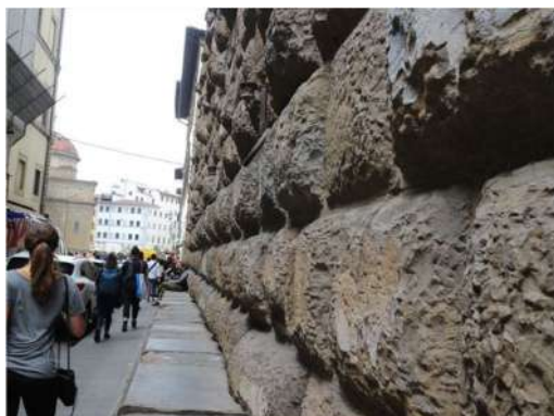
写真9 フィレンツェ メディチ・リッカルディ宮殿の壁面砂岩。表面は黄色、削られた部分は暗灰色。
