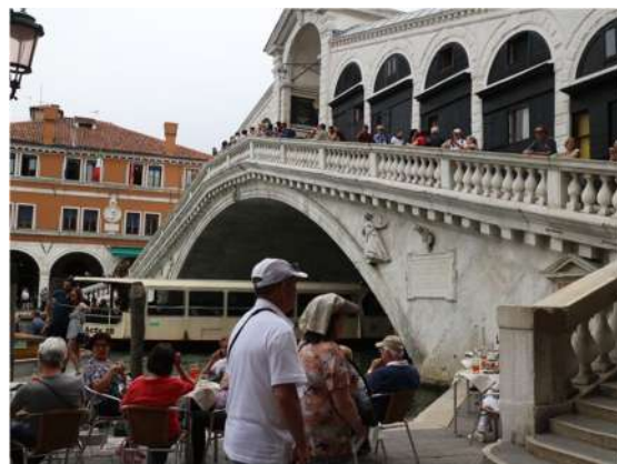
写真8 ヴェネツィア リアルト橋 大理石からなるアーチ橋。橋の下を通過しているのは水上バス。当地では、しばしば橋の上に建物が構築されている。アーチは強い。
