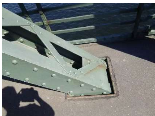
写真3 トラス斜材埋込み部の様子
