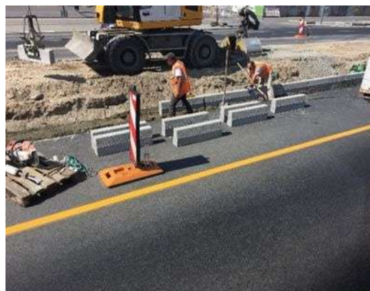
ヘルメットを被っていない作業員
