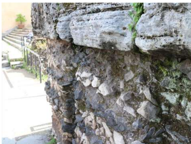
写真6 フォロ・ロマーノ ティトスの凱旋門の基礎部 古代コンクリートが露出している。もともと石積が何かで囲われていたと推測される。
