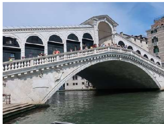
写真-9 リアルト橋
