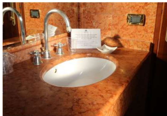
写真7 ヴェネツィアのホテル浴室壁面の石灰岩藻類とその間隙を埋める石灰泥からなる。赤茶色。
