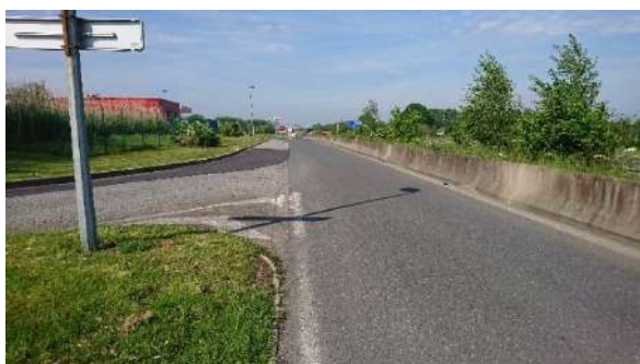
高速道路ランプ部
