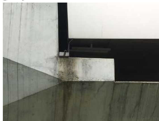
ドイツの橋梁排水処理
