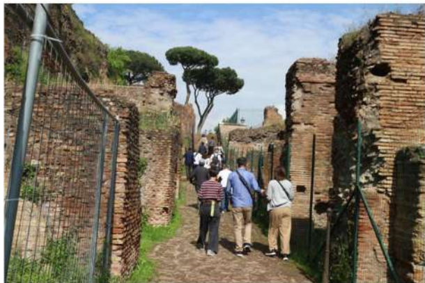
写真4 フォロ・ロマーノ・パラティーノの丘のレンガ建築物板状のレンガの間に古代のコンクリート(モルタル)が使用されている(写真7)。奥に見える樹木は地中海松。
