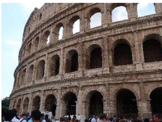
写真-17 有名なコロッセオの外壁
