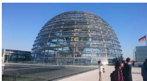
写真 3-1 議事堂のガラスドーム
