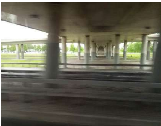
写真1 アウトバーンを跨ぐ橋の橋脚
