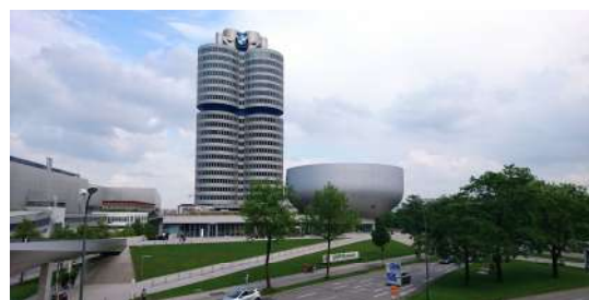
写真7 シリンダーを模したBMW本社ビル
