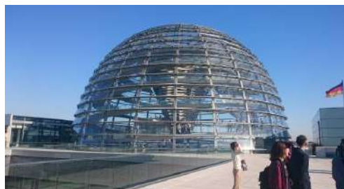
写真 3-1 議事堂のガラスドーム
