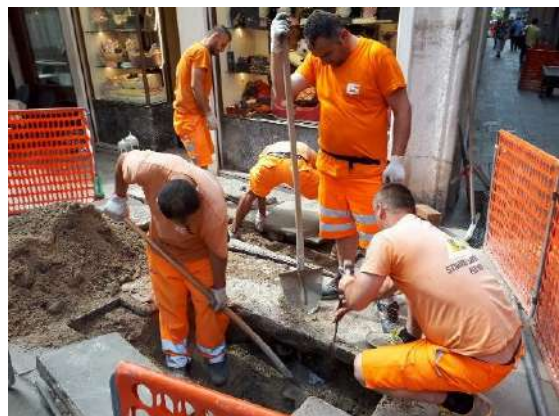
写真 3-5 オレンジが映える工事現場
