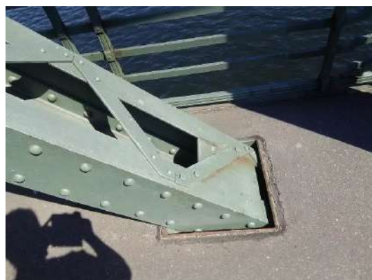
写真3 トラス斜材埋込み部の様子
