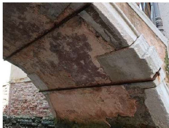
写真-8 小さなアーチ橋(下面)
