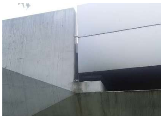
写真4 伸縮装置の排水処理
