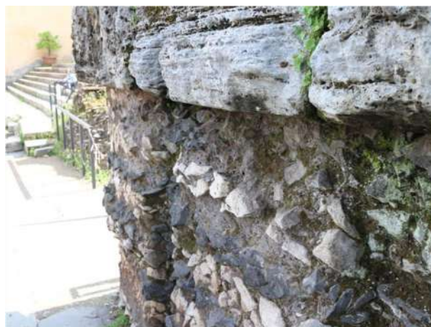
写真6 フォロ・ロマーノ ティトスの凱旋門の基礎部 古代コンクリートが露出している。もともと石積か何かで囲われていたと推測される。
