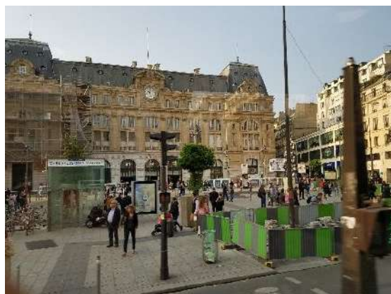
写真9 補修中の建物や歩道
