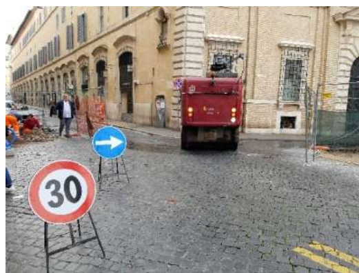
写真 4-3 フロントでブラシが回転している清掃車、左のほうでは石畳を剥がして工事中
