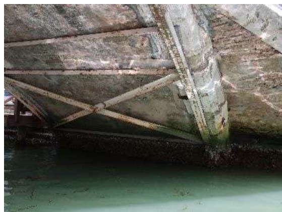
写真-6 端部が拡幅された橋(下面)
