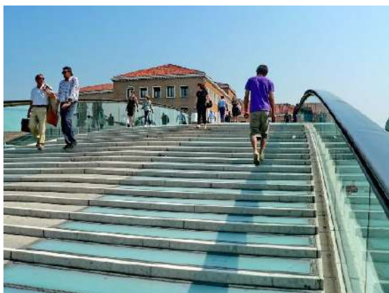
写真-11 デラ橋(橋面)
