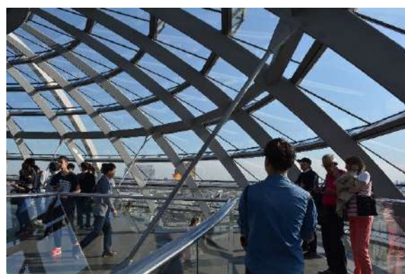
スロープから手の届く範囲にある吊り材
