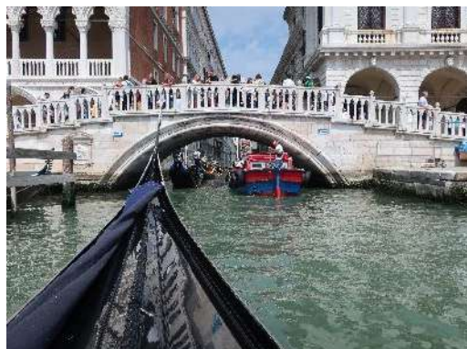
写真-1 サン・マルコ広場近くの橋(側面)
