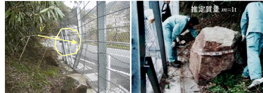
写真 5 落石へ防護柵の破損状況と衝突した落石
