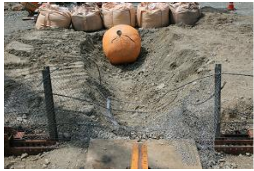
写真 9 コンクリート塊が防護柵を突破 21)
