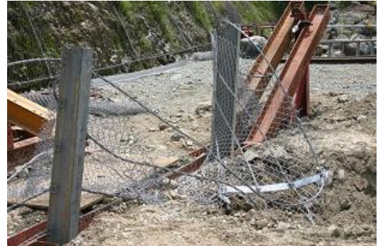
写真 10 破断した防護柵 21)
