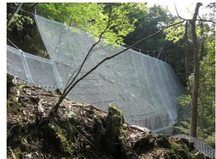
(e) 安倉林地荒廃防止工事 (北川村)
