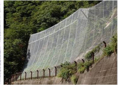
(b) 国道 195 号防災工事 (香美市物部)
