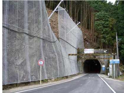
(d) 国道 319 号防災工事 (四国中央市)
