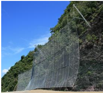
(c) 造成地のり面落石対策 (須崎市)
