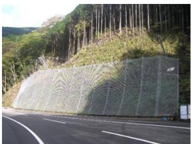
(d) 県道猪伏西谷線 (愛媛県)
