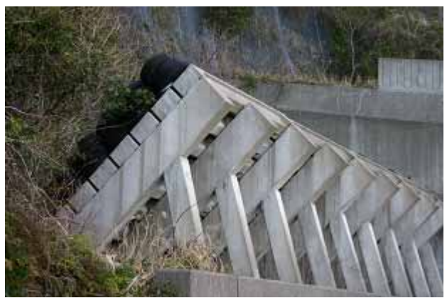
バリヤーと呼ばれるプレキャストコンクリート製の待ち受け式落石防護柵。
