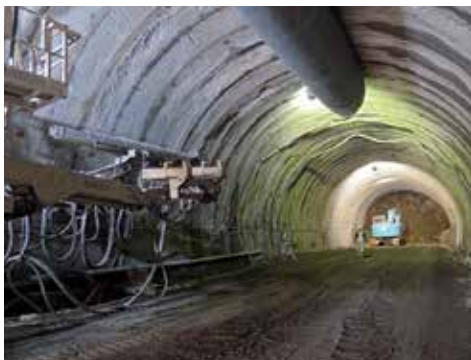
一般国道493号小島トンネル(高知県安芸土木事務所)
