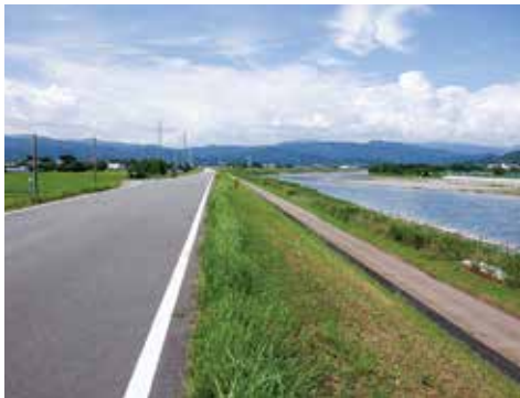
一級河川物部川(四国地方整備局高知河川国道事務所)
