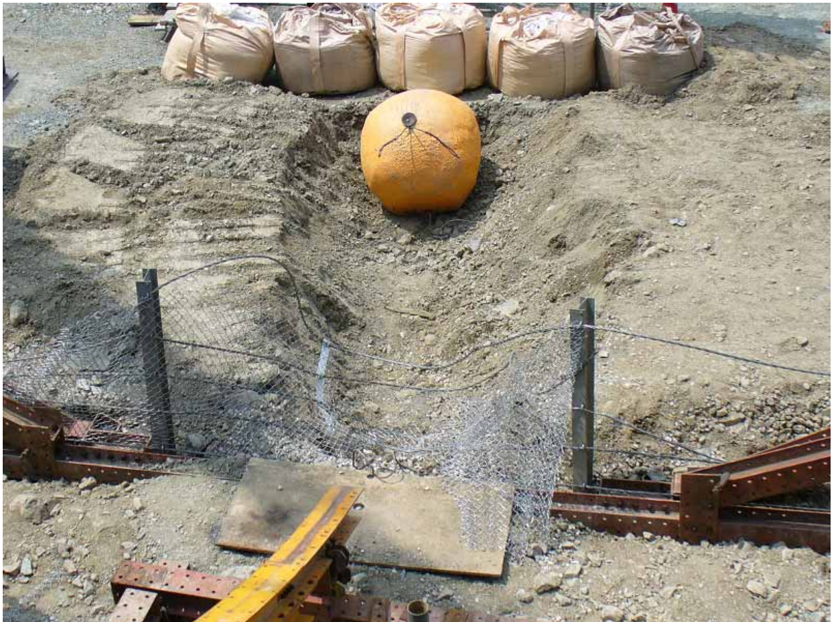
写真 9 コンクリート塊が防護柵を突破して、溝の端まで転がって停止した。
