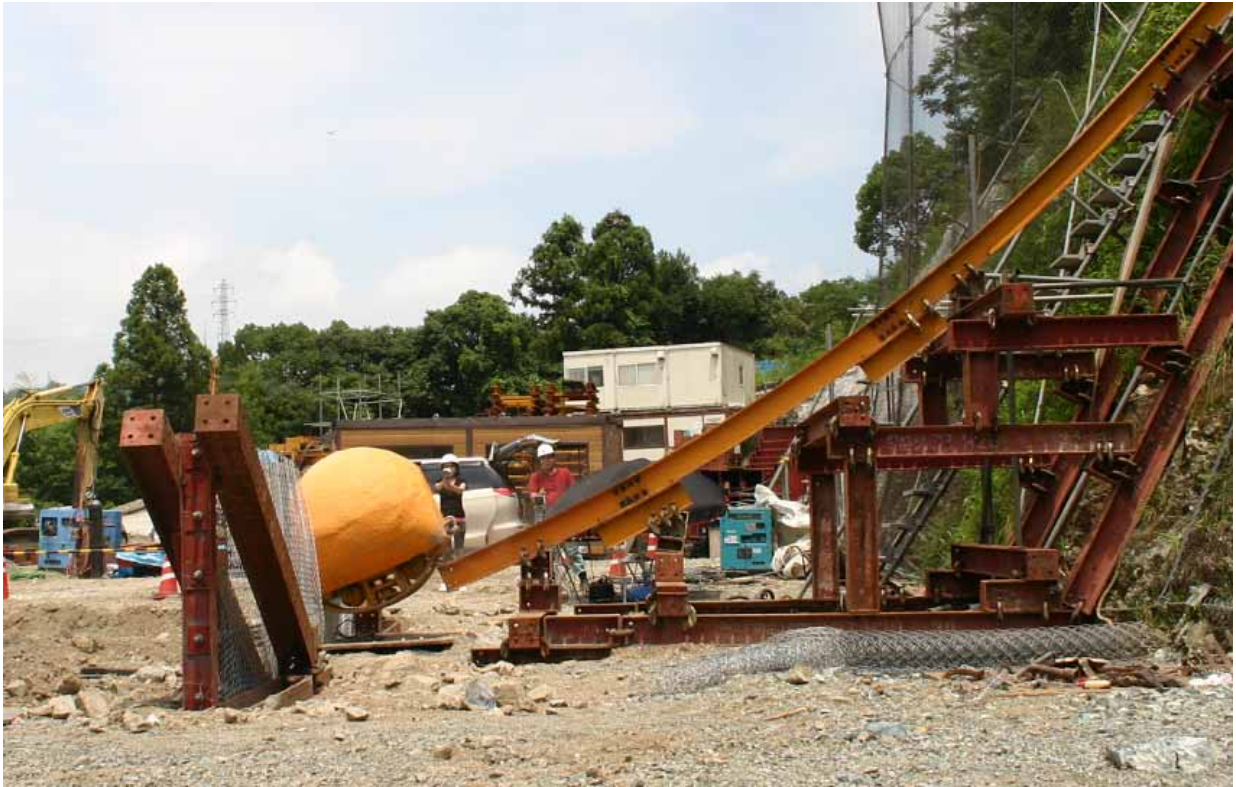
写真 8 コンクリート塊が防護柵に衝突する直前
