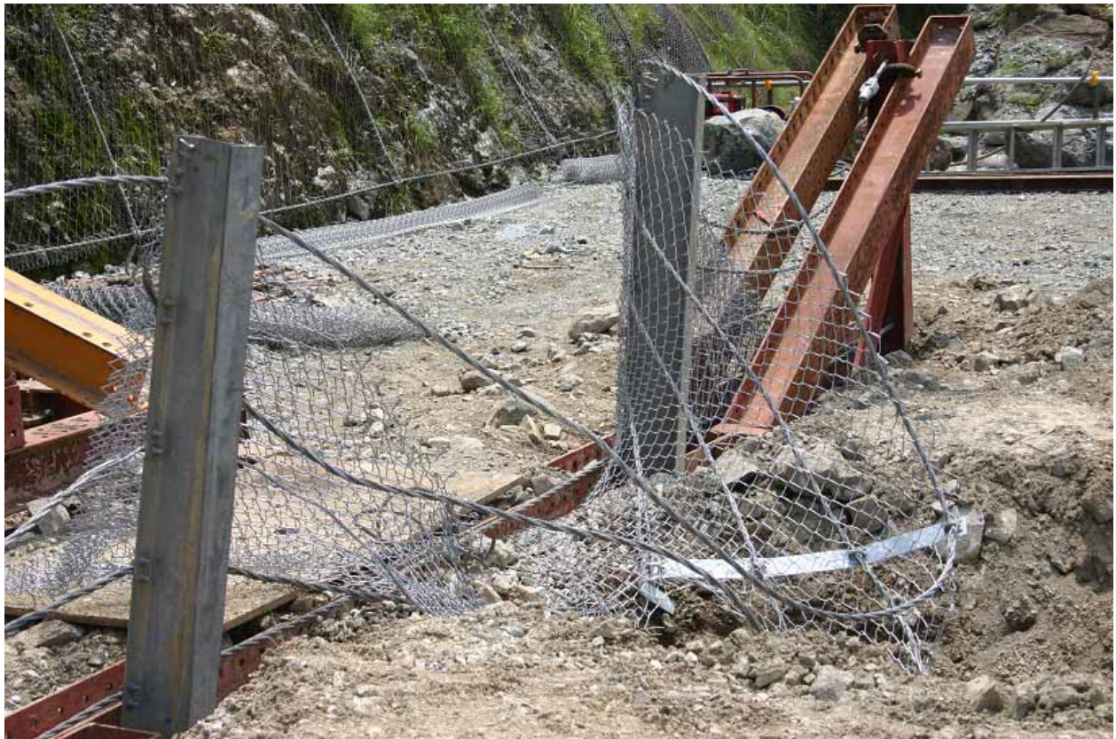
写真 11 防護柵の破損状況。最上段のロープは、ワイヤチャックから引き抜けている。
