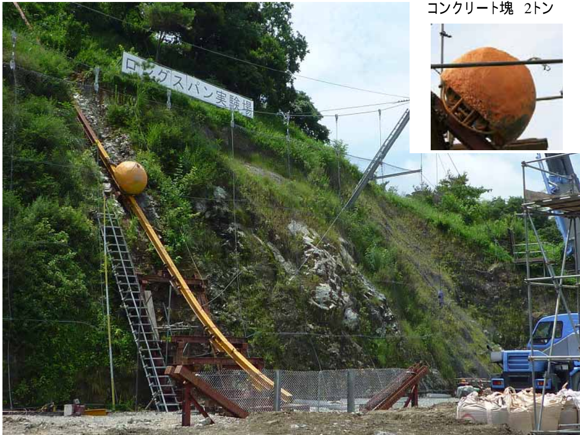
写真 6 末端支柱を H 形鋼で補強。コンクリート塊はレール下端より 8m 上方へ固定。
