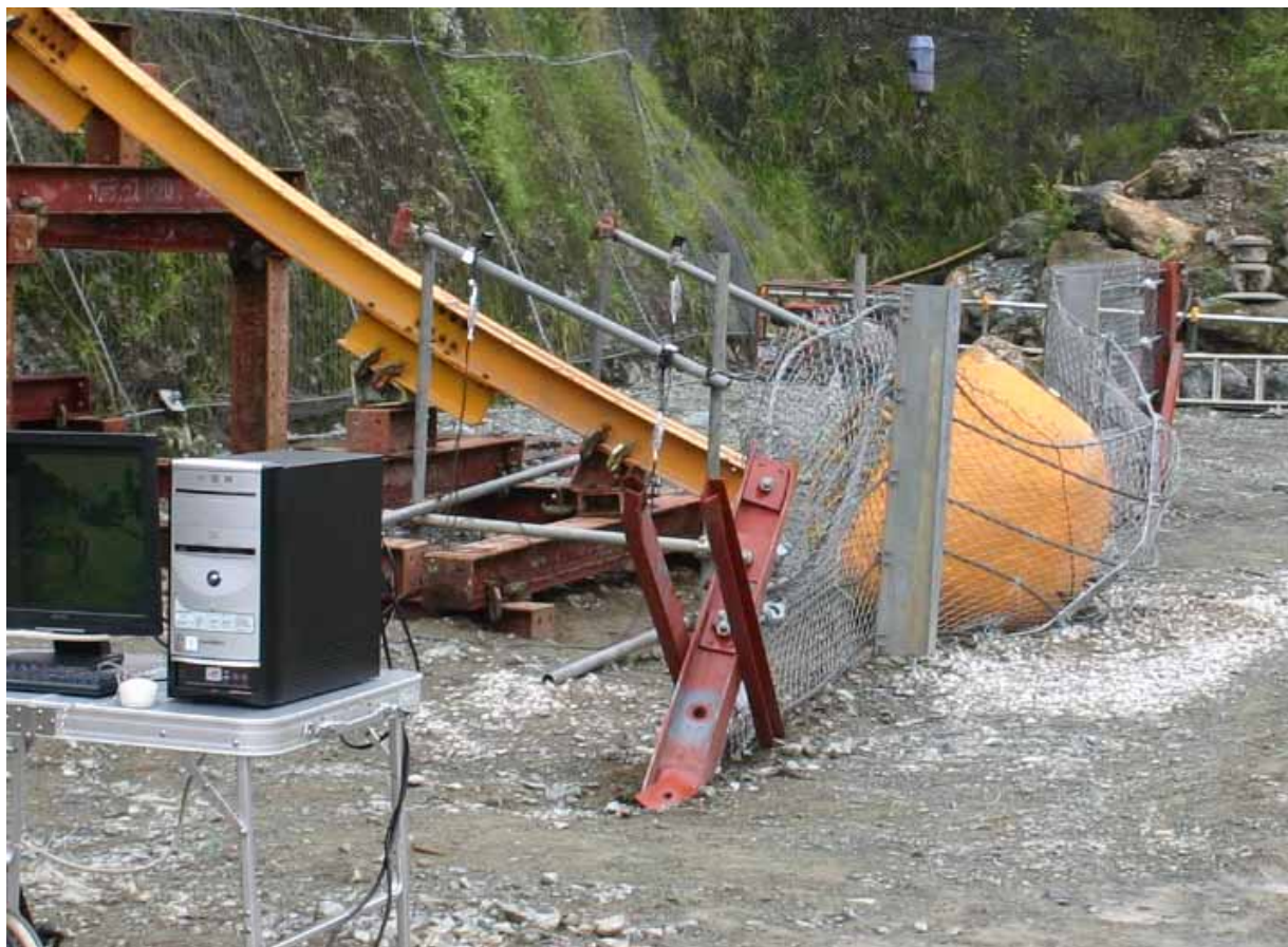
写真 3 防護柵の破損状況。端末支柱が倒れ、2 段目の引付棒が破断。
