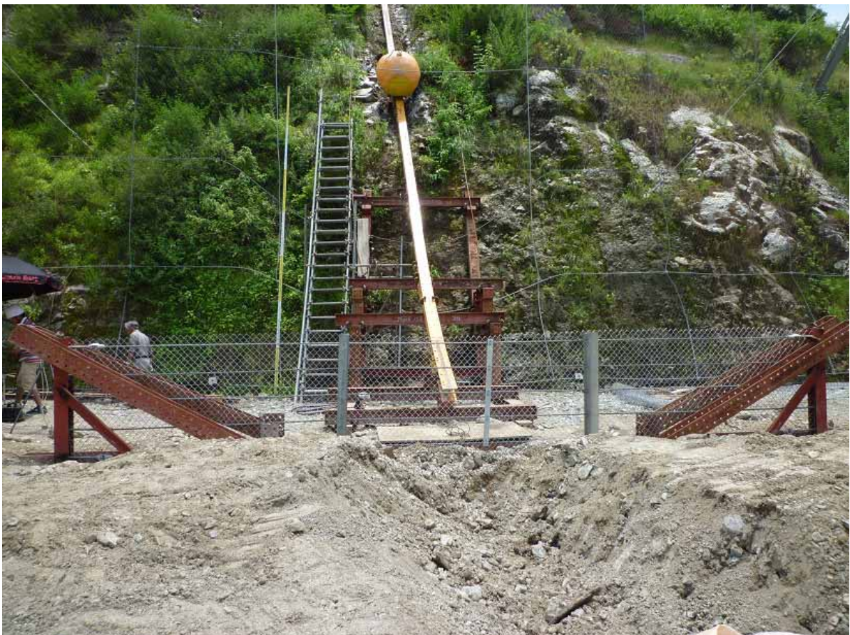
写真 7 防護柵の前方の地盤を溝状に掘り下げた。
