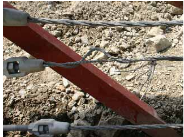
写真 12 上のロープはストランドが1本抜けている 写真 13 ャックからストランドの抜け出し
