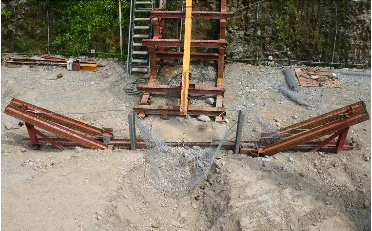
写真 10 ワイヤロープが破断。金網は中央スパンに引き寄せられた。
