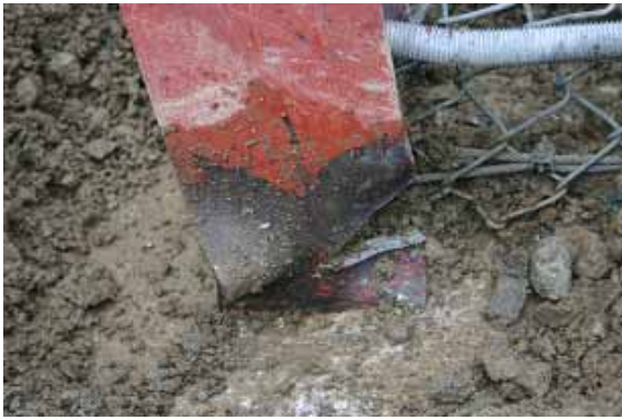
写真 4 倒れた端末支柱の根元
