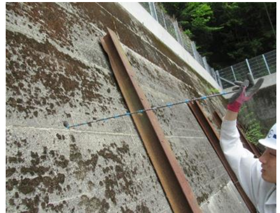
写真 5 擁壁背面調査の様子
