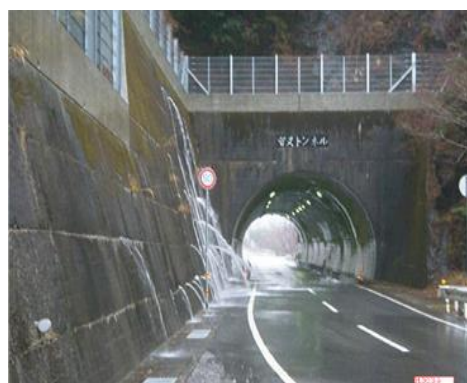
写真 3 水抜き孔からの排水状況
