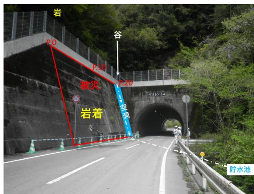
写真 1 被災現場の様子
