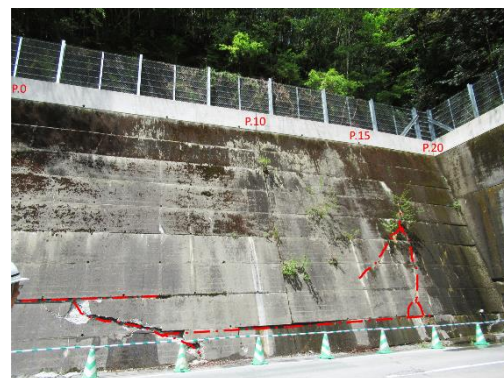
写真 2 被災擁壁の変状
