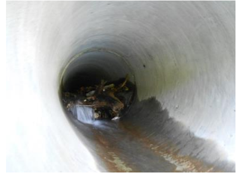
写真 4 暗渠の流木及び土砂堆積
