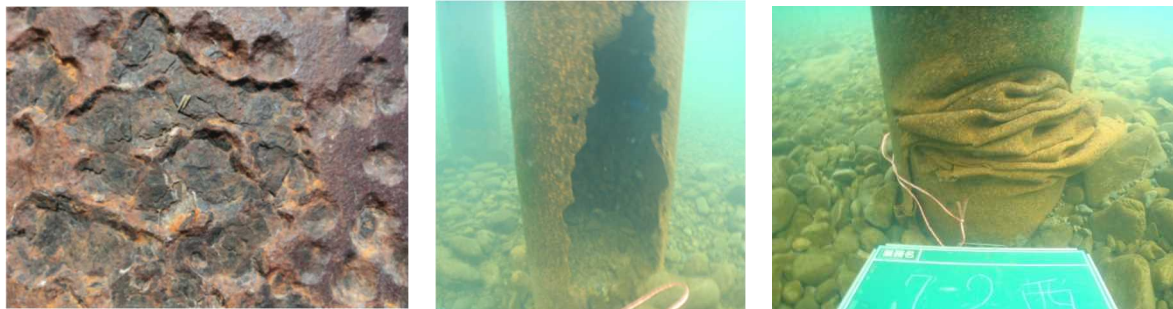
写真 3 鋼管の損傷発生状況(左：あばた状の凹み、中：大規模な孔食、右：座屈)
