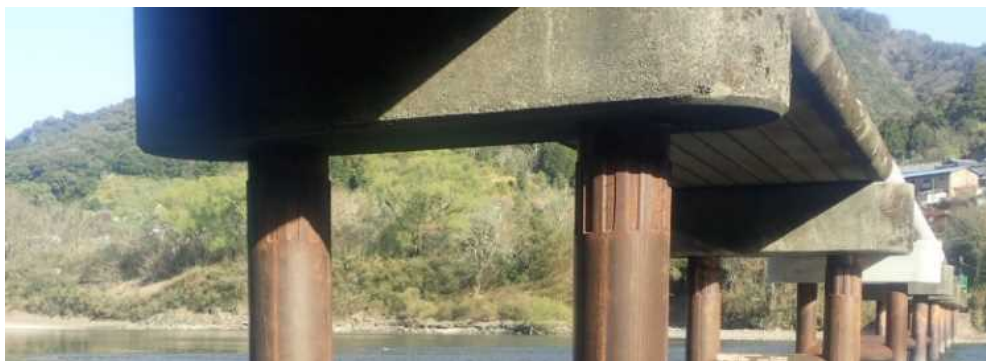
写真 4 当て板補修後の定着部の状況
