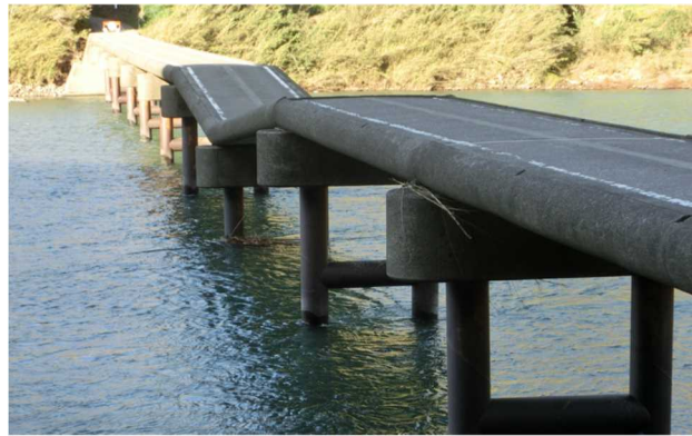
写真 1 沈下橋の損傷状況
