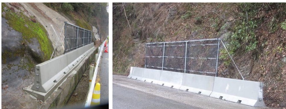
製品を現地へ設置した状況
