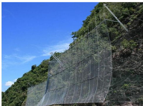
現地に施工されたロングスパン工法
