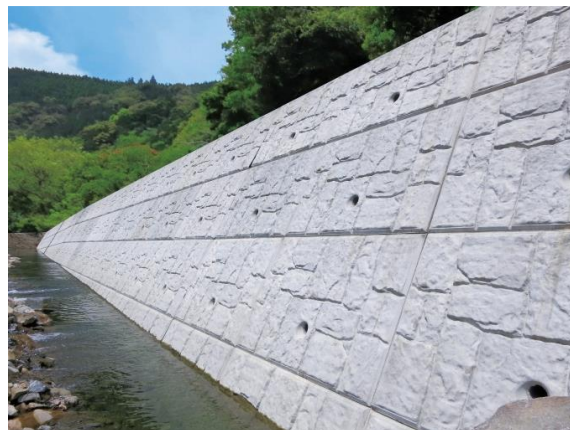
完成した護岸
