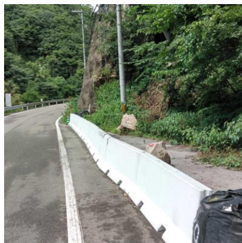
高知東部自動車道に設置された TP プレガード 落石防護擁壁として設置された TP プレガード
