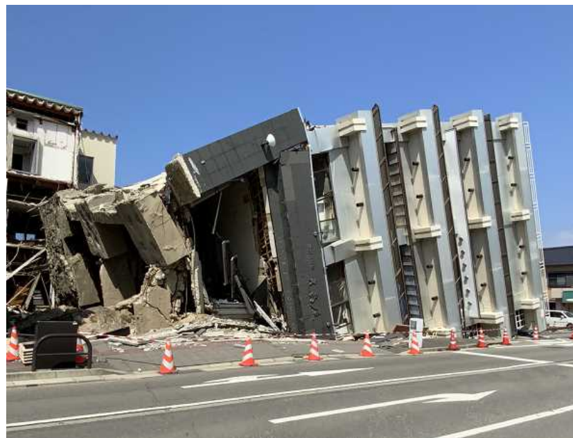
倒壊した漆器店「五島屋」の7階建てビル
